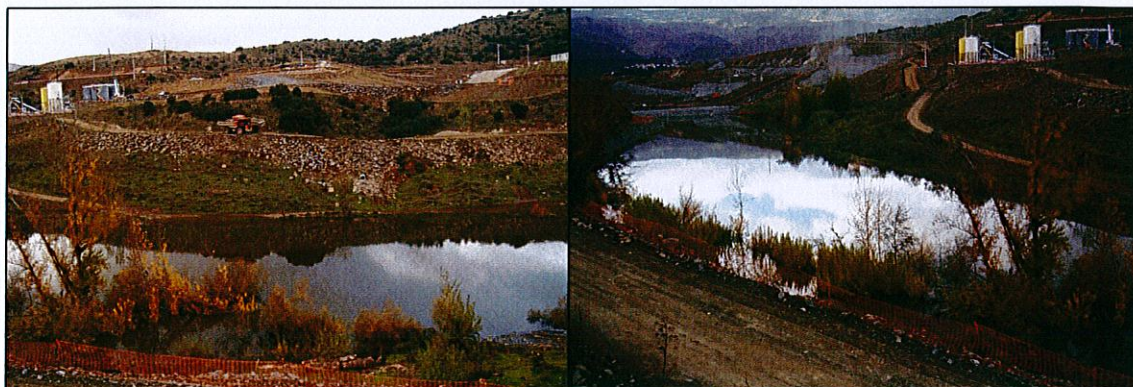
PANORÂMICA DO LOCAL L4 – ZONA DE OBRAS DO ESCALÃO DE JUSANTE
